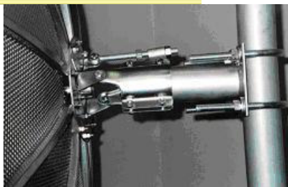
Figura H – Fixação da Antena no Montante.
