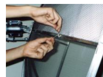
Figura G – Fixação das telas nas longarinas com arame de alumínio
