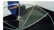
Figura E – Fixação dos demais arcos e das telas correspondentes.
